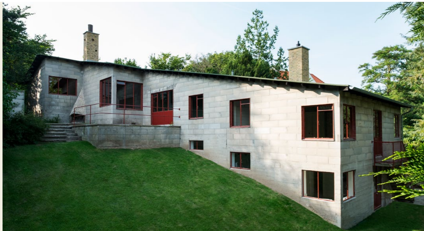
PH's hus er blevet isoleret udefra med en tynd isolering kaldet Aerogel.
