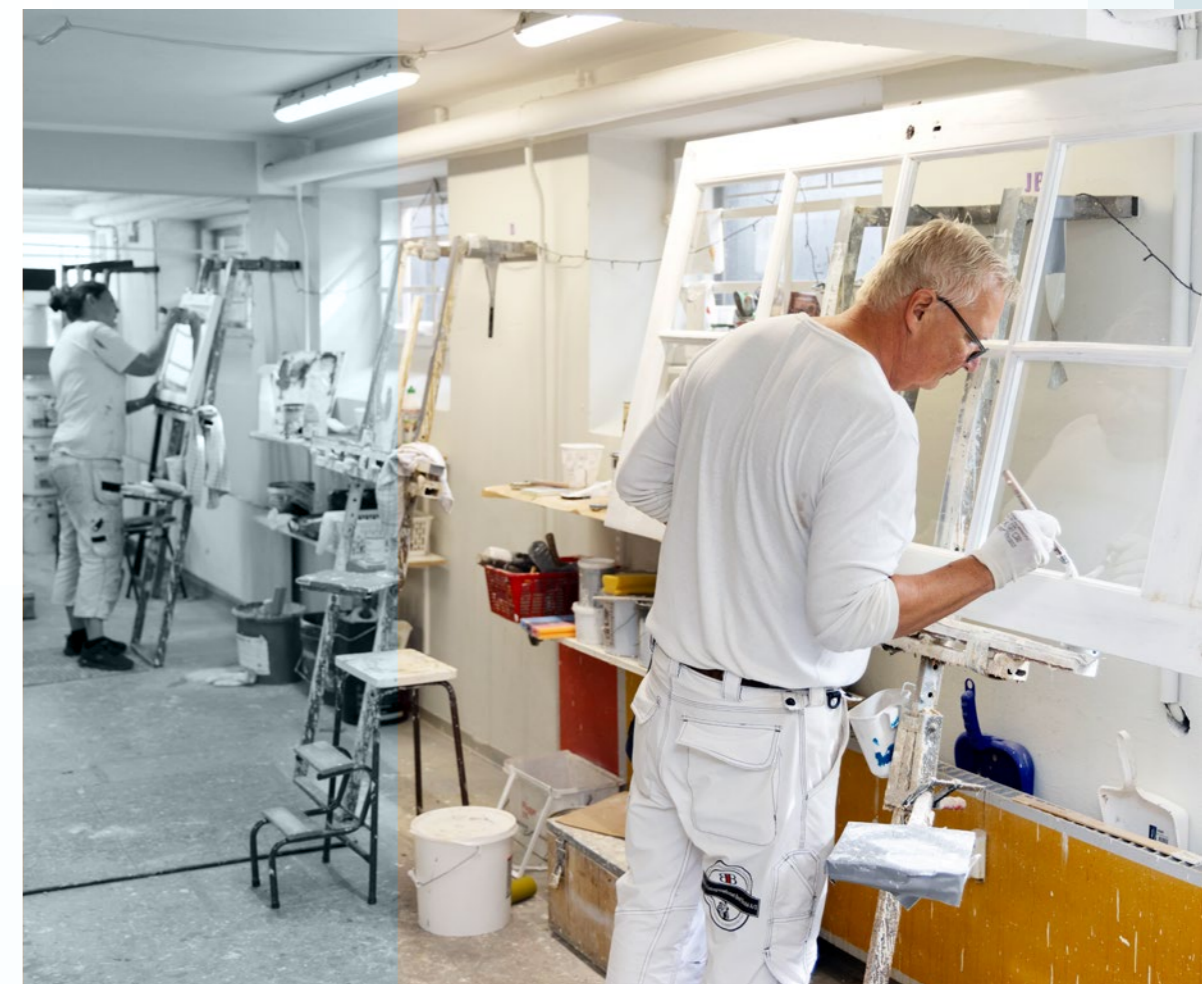
Malerne Bjørn og Line er igang med at male træværket med linolinemaling
